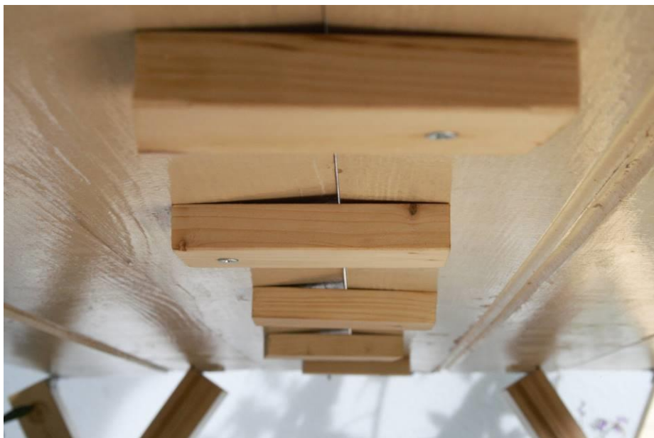
Abbildung 42 Verkeilen der Tischplatten
