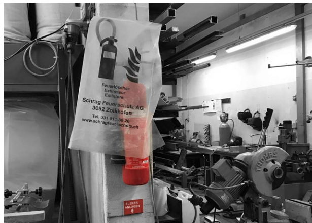
Feuerlöscher (CO2 für Geräte)
